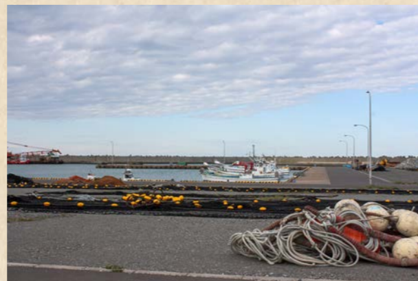
4 浜猿払漁港 昭和53年～平成13年に修築工事で整備された。
