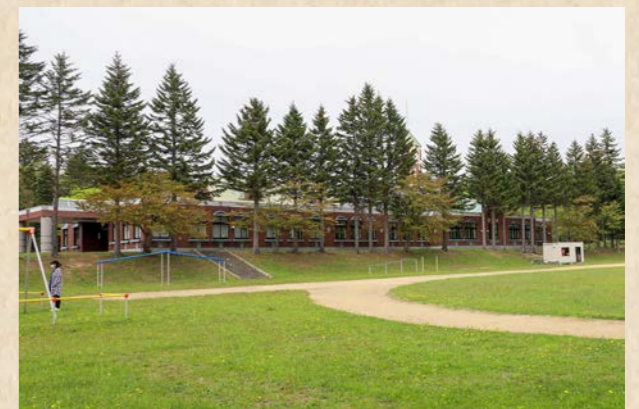
6 浅茅野小学校 平成5年には建設中だった浅茅野小学校。平成7年に完成となった。
