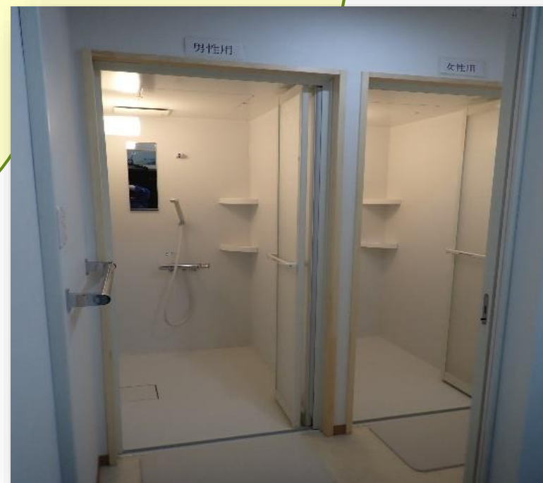
シャワー室（一部共用）
